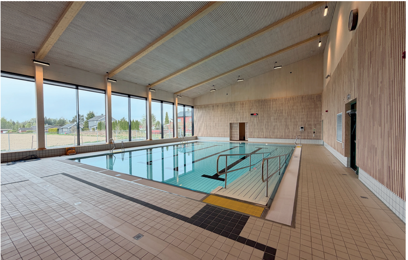
Det er bygget et 12,5 meter langt svømmebasseng, med heve/senk-funksjon.
